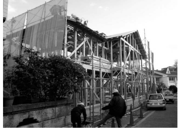
(棟上げを終えた、建物の全体像)
