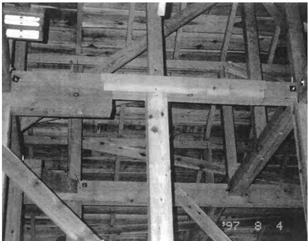
約9mの桁に5本もの端材を使って、その継手はいいかげんに施工している。筋違いの有る壁の中で15cm程の飼木(?)を設けているが、大きな断面の材は連続していない。これでは力に対して筋違いが有効に働くかない。
