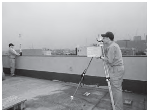
レベル計による不同沈下調査
