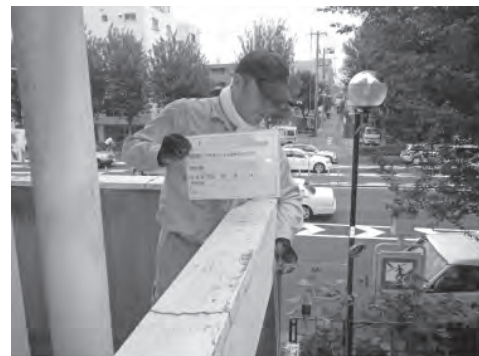
下げ振りによる建物の傾斜調査
