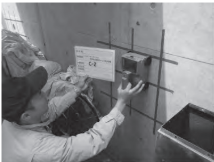
調査状況写真
