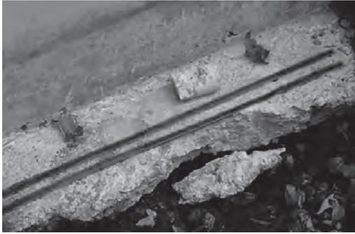
くつもの貫通クラックが発生しているのを発見し、底盤も疑って土を掘ってみたところ、この手抜き工事を発見したのです。写真4、5は、貫通クラックであることを証明するためにコア抜きし
