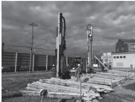
丸太杭の搬入状況
