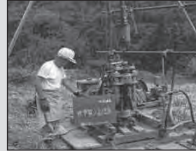
ボーリング調査+標準貫入試験
