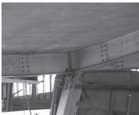
柱溶接部の破断
